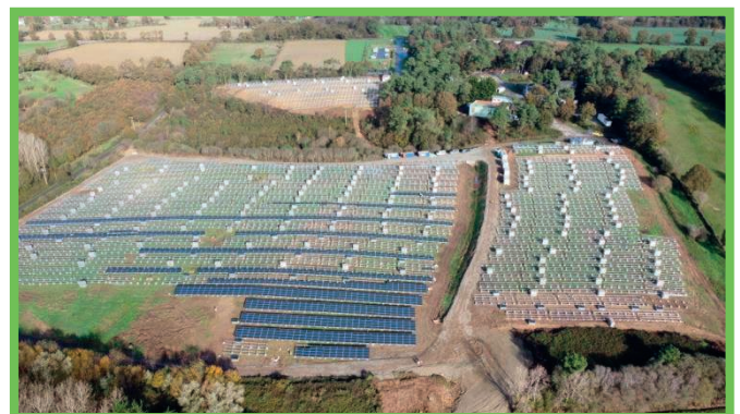
Le site pendant la construction
