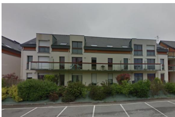
Logements collectifs réalisés en 2006 rue Gimbert
